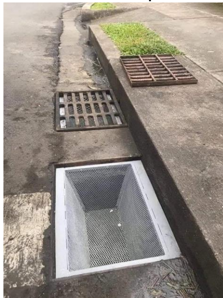
Figura 64: Cesta com malha acoplada a boca de lobo.
