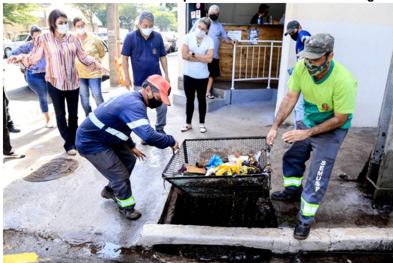
Figura 65: Cesta com malha acoplada desenvolvida em Maringá – PR.
