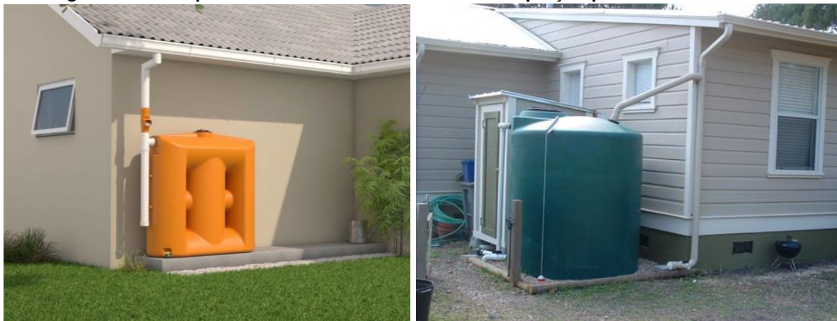
Figura 38: Exemplos de estruturas de sistemas de captação pluvial em residências.
