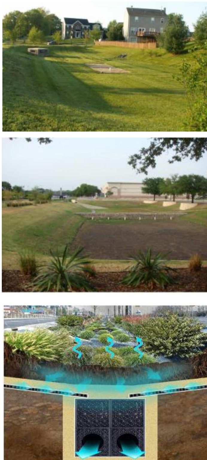
Figura 59: Exemplo de bacia de detenção seca
