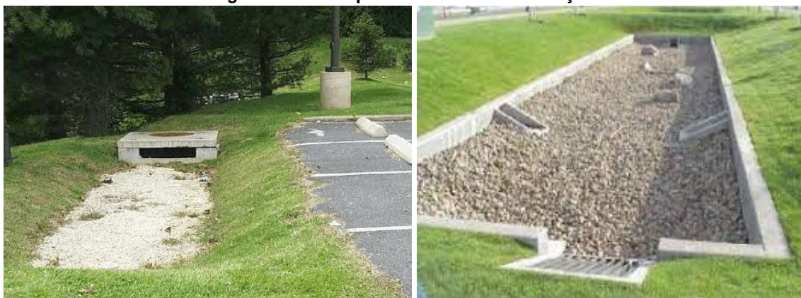
Figura 42: Exemplos de valas de infiltração.
