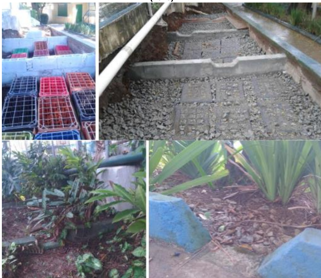
Figura 55: Planter com vertedouros com engradados de verveja reaproveitados para aumento do acúmulo de água e atenuação das vazões e infiltração em jardim em escola particular, SP (2015).
