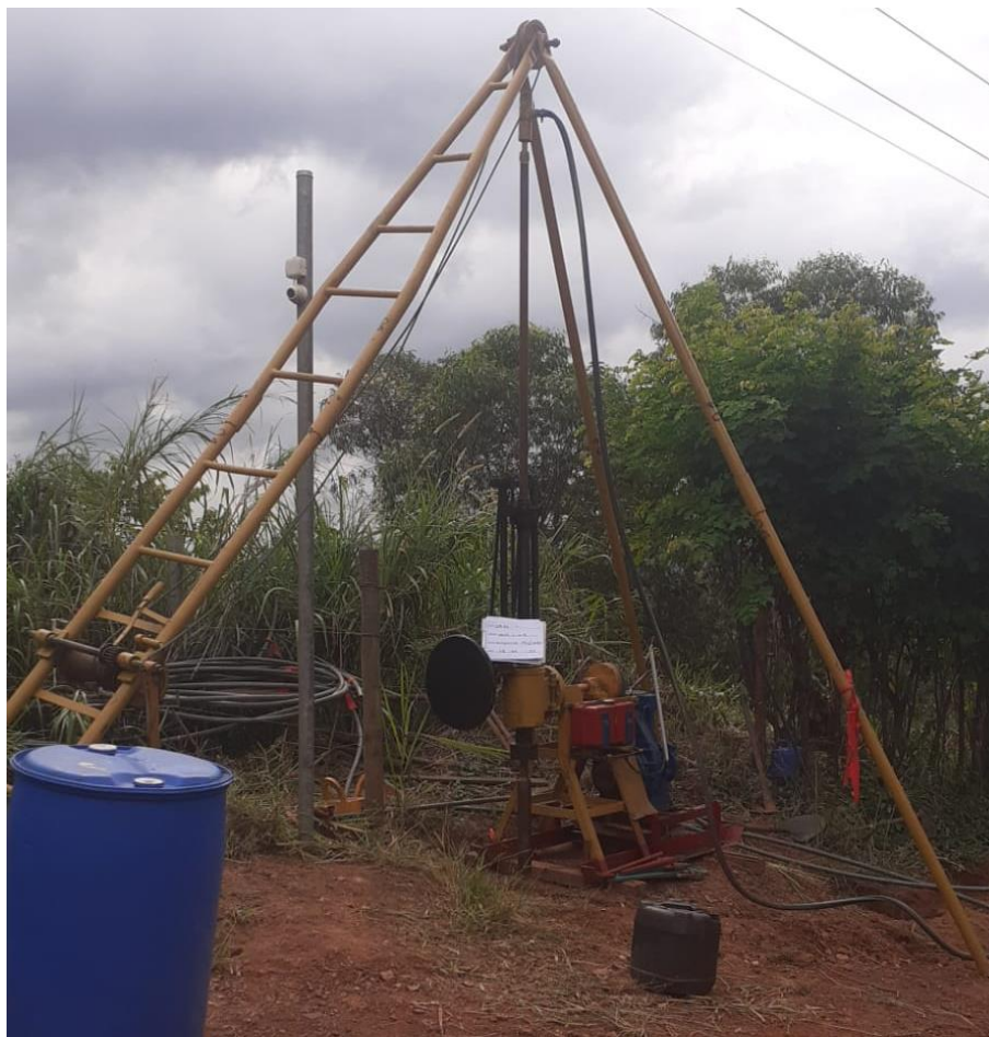
Instalação do furo SM-01
