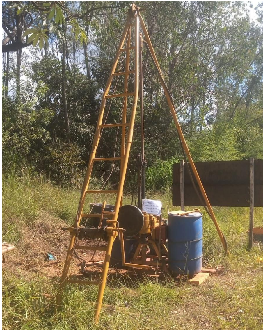
Instalação do furo SM-05
