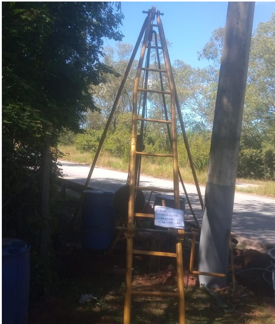
Instalação do furo SM-06
