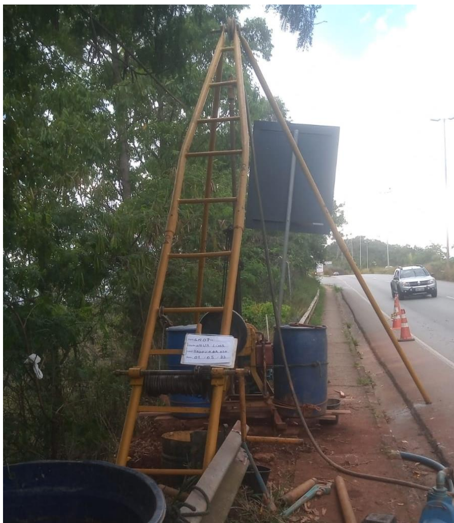
Instalação do furo SM-07
