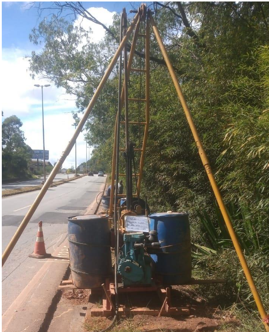
Instalação do furo SM-04
