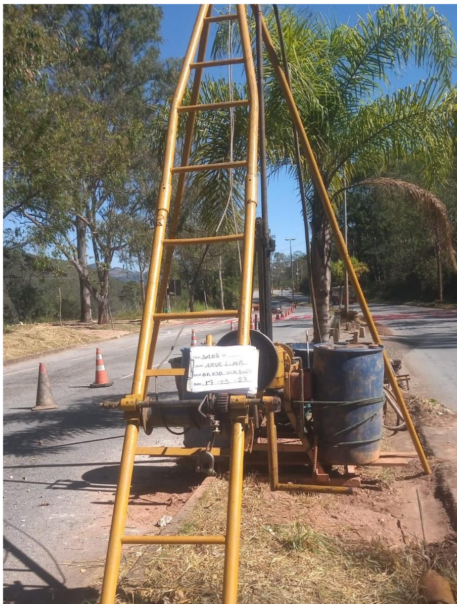
Instalação do furo SM-03
