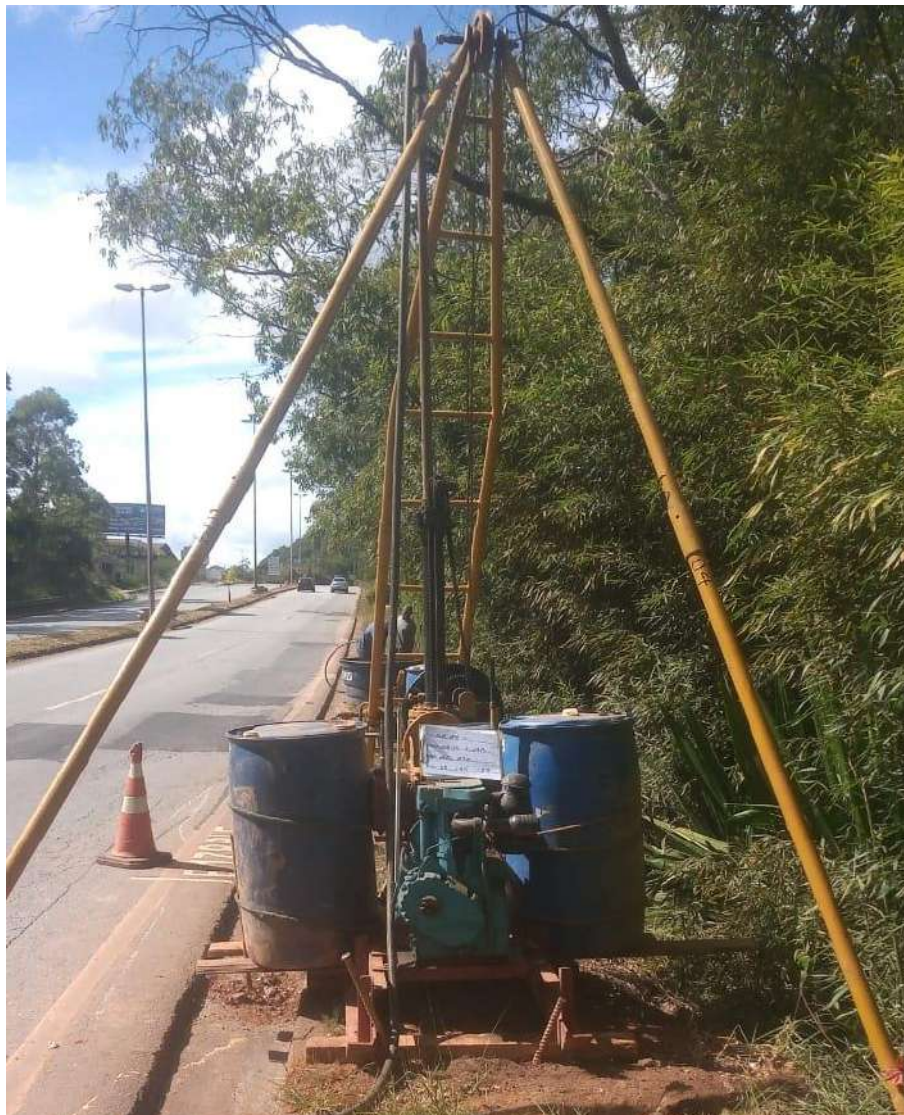
Instalação do furo SM-04
