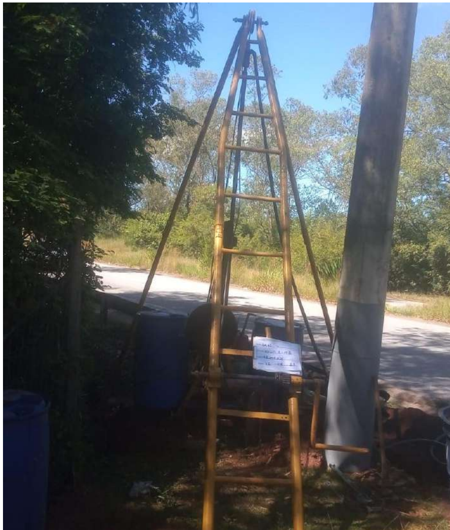
Instalação do furo SM-06
