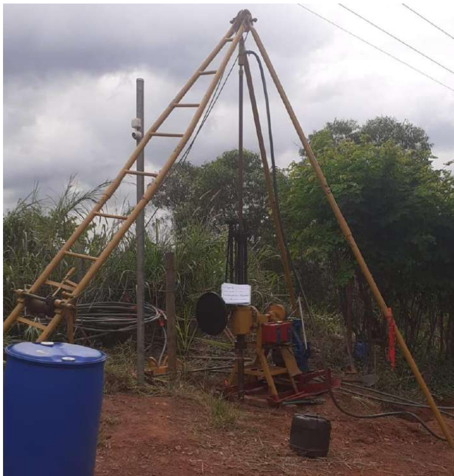
Instalação do furo SM-01
