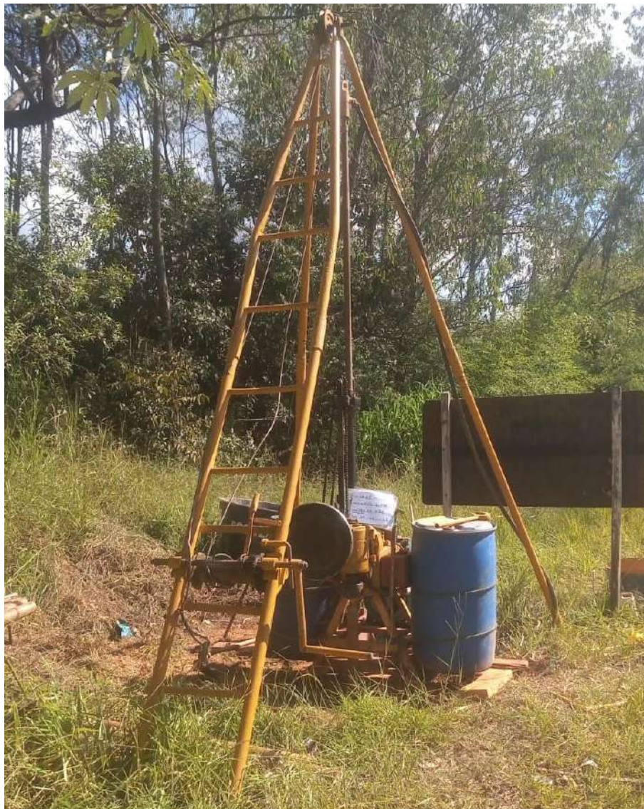
Instalação do furo SM-05
