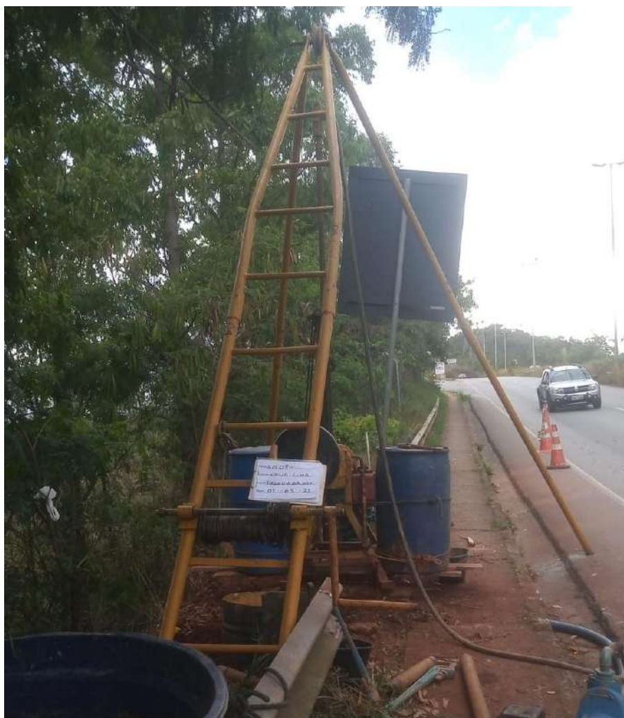
Instalação do furo SM-07
